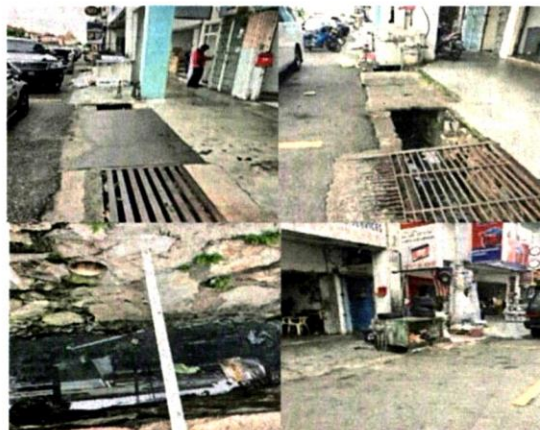
■土拉央第17路工程全长460公尺。
